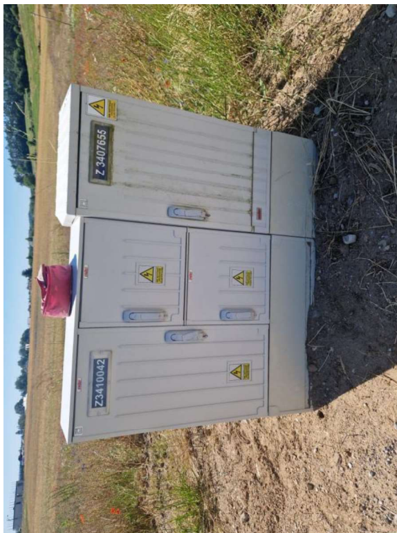
Istn. złącze Z3407655 KRSN-00/4R-NH2/F oraz istn. złącze Z3410042 P2-Rs/LZV/2LZR/F
