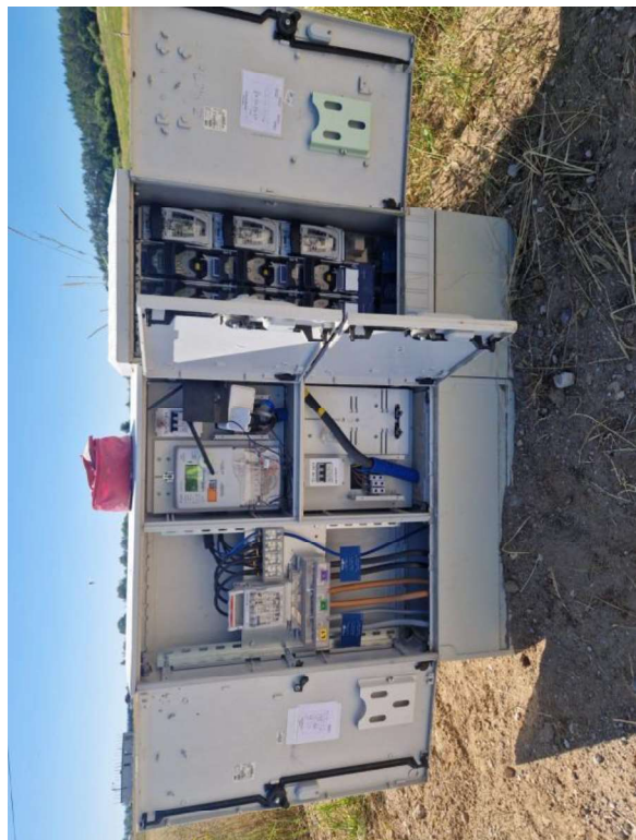
Wnętrze istn. złącza Z3407655 KRSN-00/4R-NH2/F oraz wnętrze istn. złącza Z3410042 P2-Rs/LZV/2LZR/F
