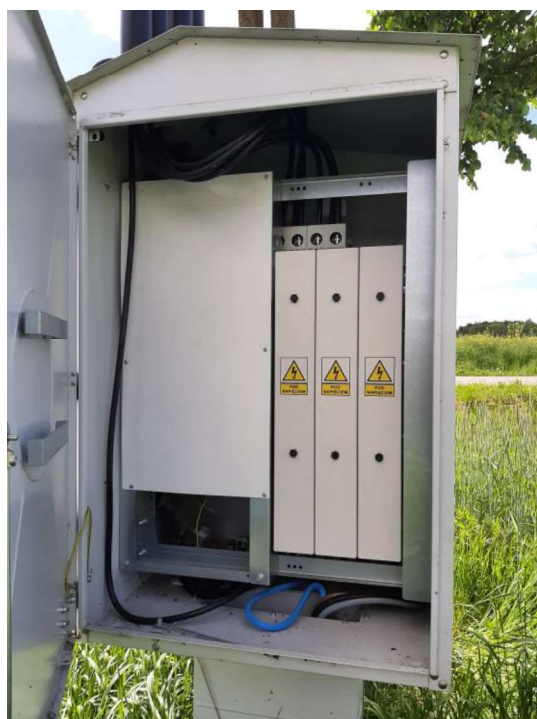
Wnętrze istn. rozdzielnicy stacji transf. SN/nN T340501 "Aplinki"
