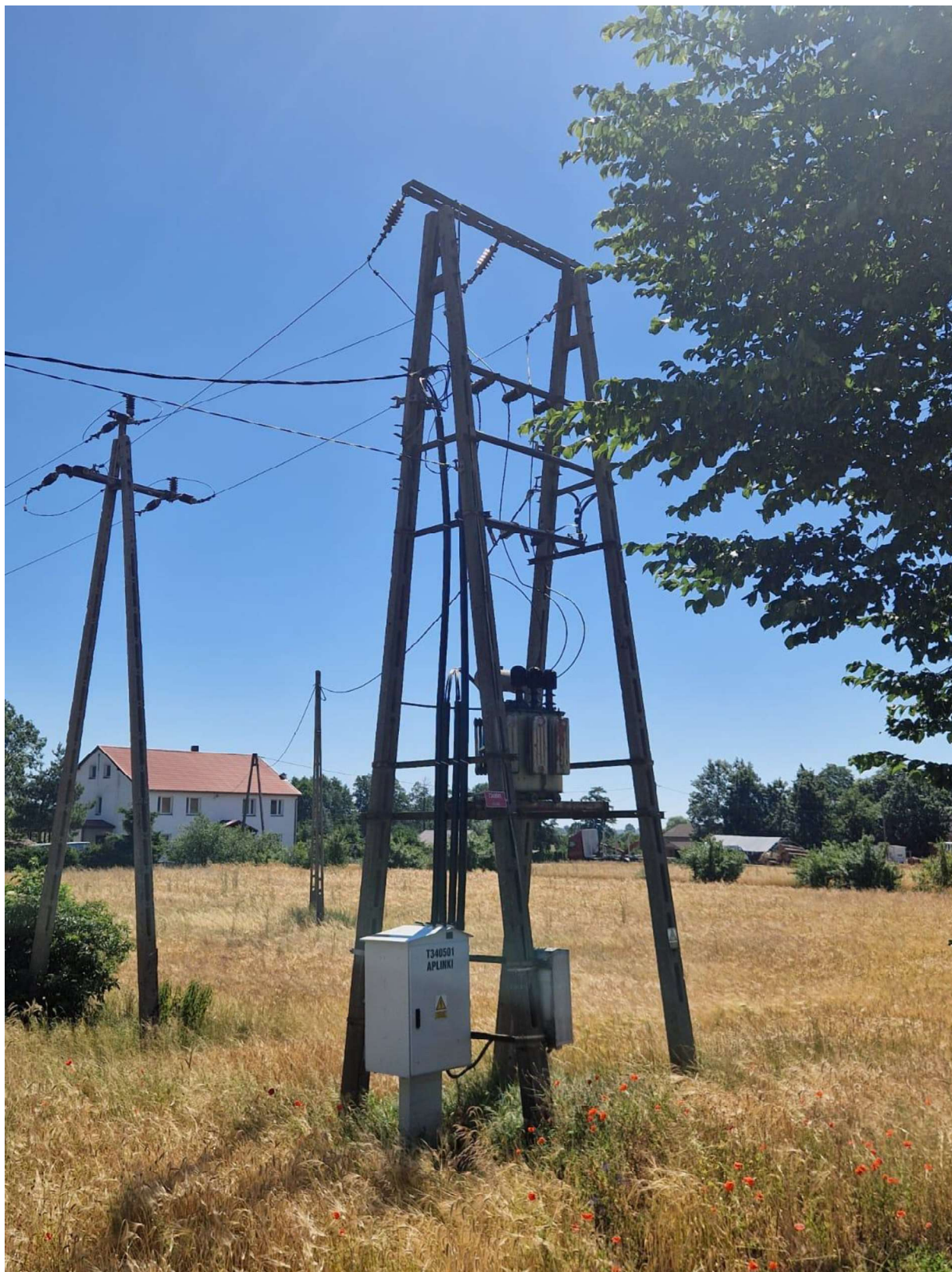
Istn. stacja transf. SN/nN T340501 "Aplinki"
