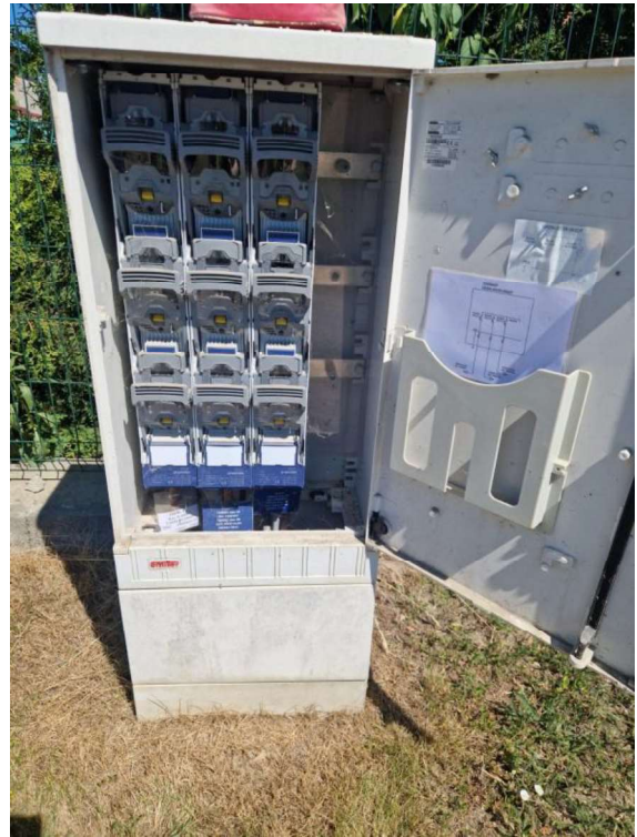
Wnętrze istn. złącza Z3406457 KRSN-00/3R-NH2/F
